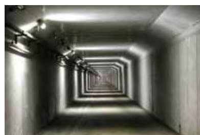
トンネル内避難通路
