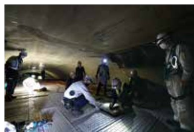
トンネル補修作業
